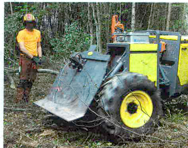
Der funkgesteuerte Knickschlepper leistet wertvolle Dienste bei der Rückearbeit.
